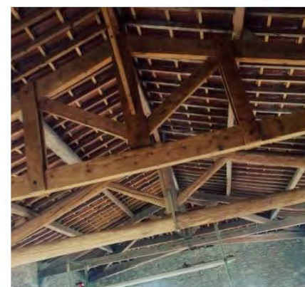
Poutres en chêne ancien 19 e siècle Rabotage & dégauchissage pour réutilisation comme charpente à ferme - Aveyron
