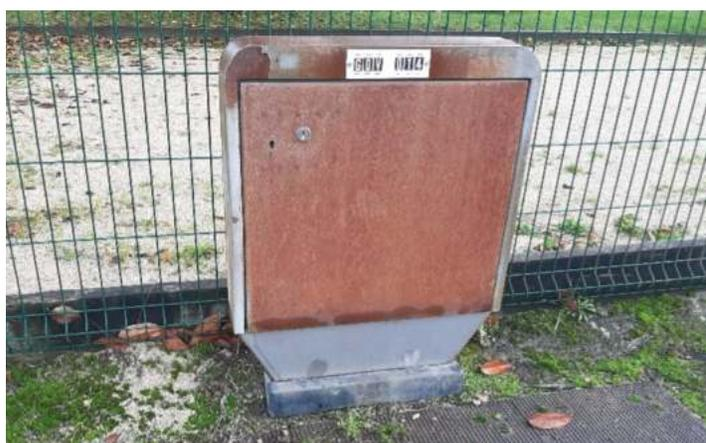
Les armoires métalliques (simple ou double face) formant les premières sous-répartitions sur la voie publique sont en tôle et profilées d'acier monté sur un socle en fonte. Elles sont démontables.
