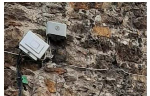
Des boîtes de distribution équipées de deux réglettes à 4 paires avec bornes à vis, pour réseau souterrain, sont fixées à 60 cm du sol, voire encastrées dans la maçonnerie.
